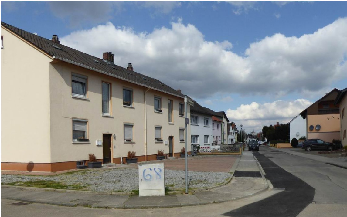
Abbildung 7: Versiegelte und teilversiegelte Flächen, hier im Abstandsbereich zwischen Bebauung und Straße (Ecke Kettelerstraße/Boxheimerhofstraße; TG 2)
