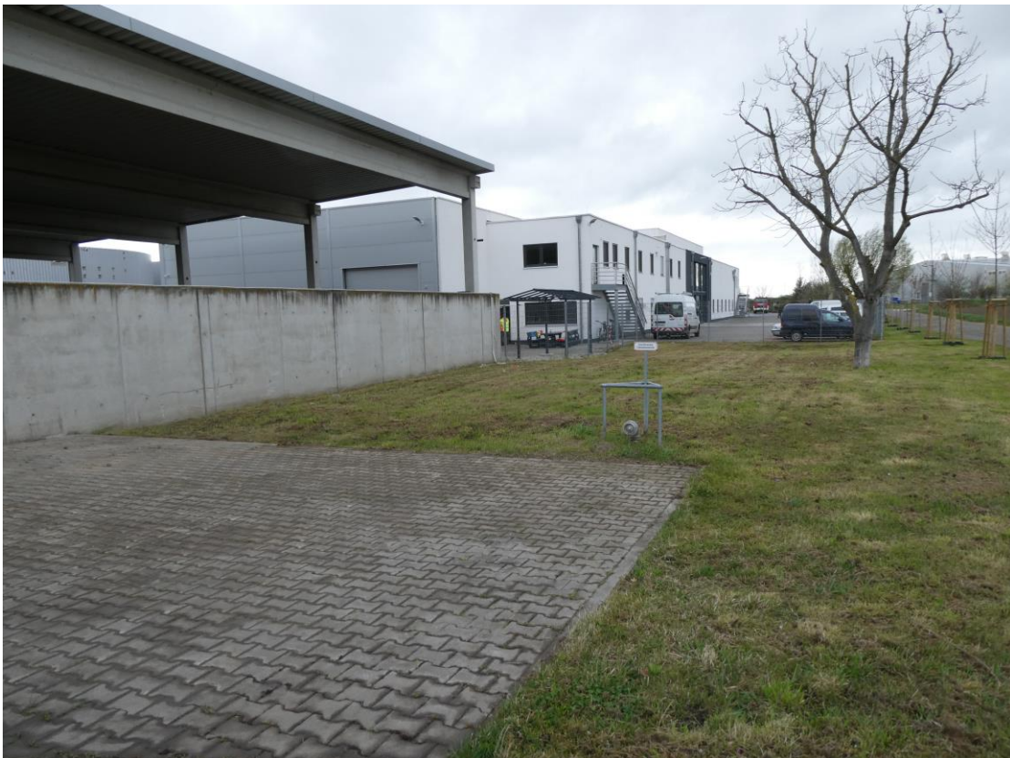
Abb. 19: Offene Halle und Verwaltungsgebäude der Biogasanlage
