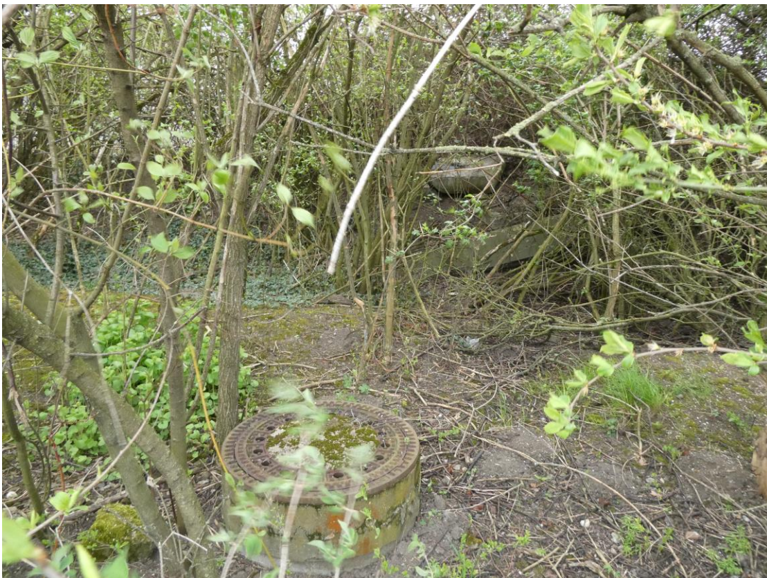
Abb. 13: Verrohrtes ehemaliges Bachbett des Steinlachgrabens
